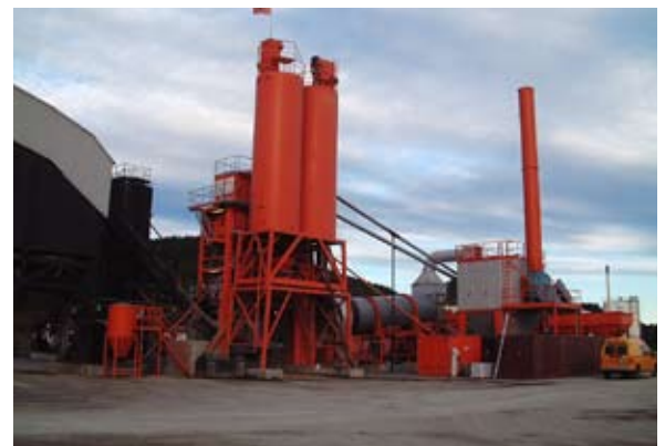
Asfaltfabrikk og miljømåling (støvutslipp).
